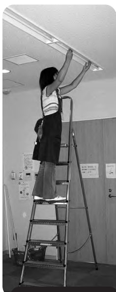
蛍光管の取り替え
